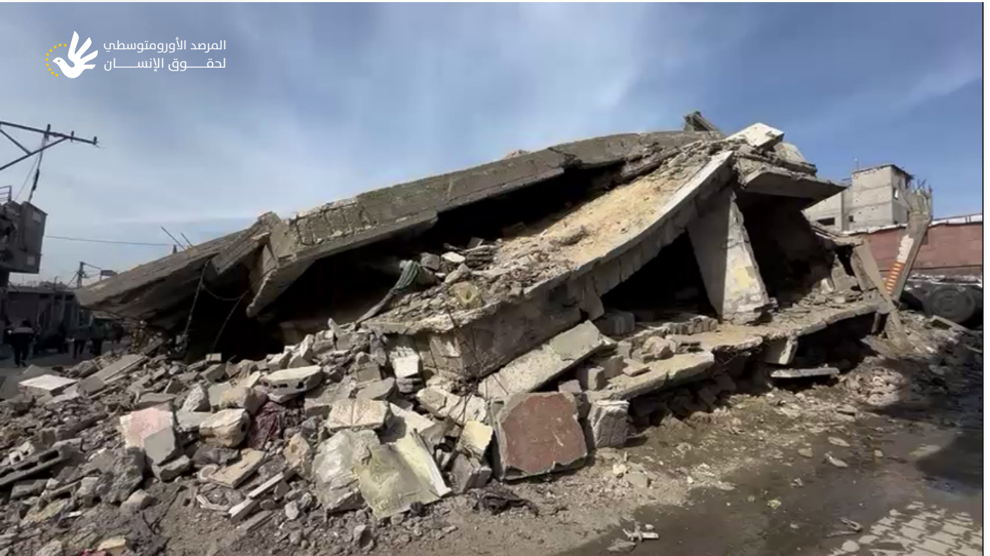
صورة تظهر ركام مبنى عائلة جحا السكني بمنطقة الشعف الذي دمرته طائرات جيش الاحتلال الإسرائيلي بشكل كامل. المصدر: المرصد الأورومتوسطي لحقوق الإنسان.
