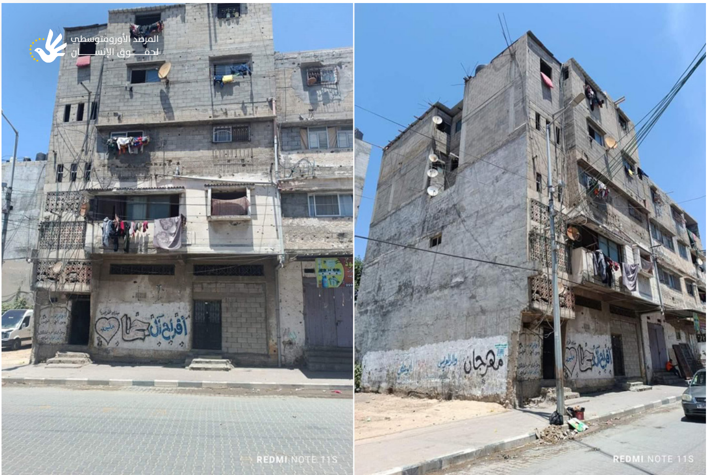
صور تظهر مبنى عائلة جحا السكني قبل استهدافه حيث يظهر منزلين متلاصقتين من أصل ثلاثة منازل متلاصقة بمنطقة الشرف شرق مدينة غزة. المصدر: الشهود الذين قابلهم فريق المرصد الأورومتوسطي لحقوق الإنسان
