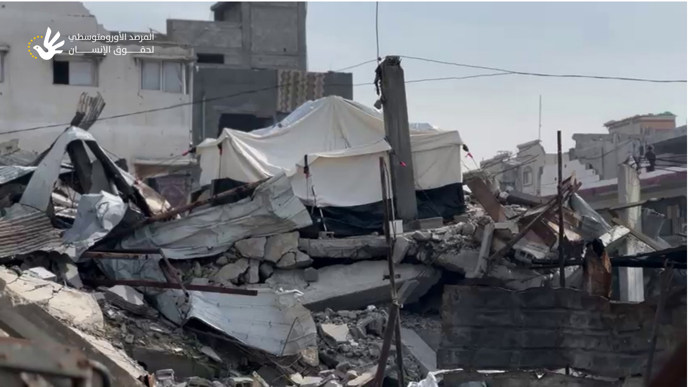
صورة تظهر ركام مسجد الرضا المدمر بالكامل المقابل لمبنى عائلة جحا المستهدف بمنطقة الشعف. المصدر: المرصد الأورومتوسطي لحقوق الإنسان.
